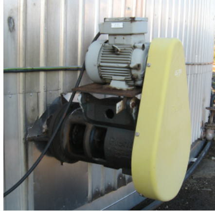
Sähkökäyttöinen sekoitin asennettuna bitumin varastosäiliöön.
