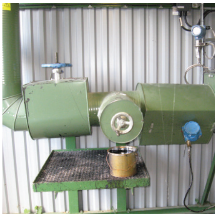
Provtagningspunkt för bitumen.
