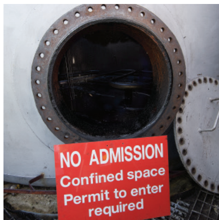
Rengöring inuti en lagringstank.
