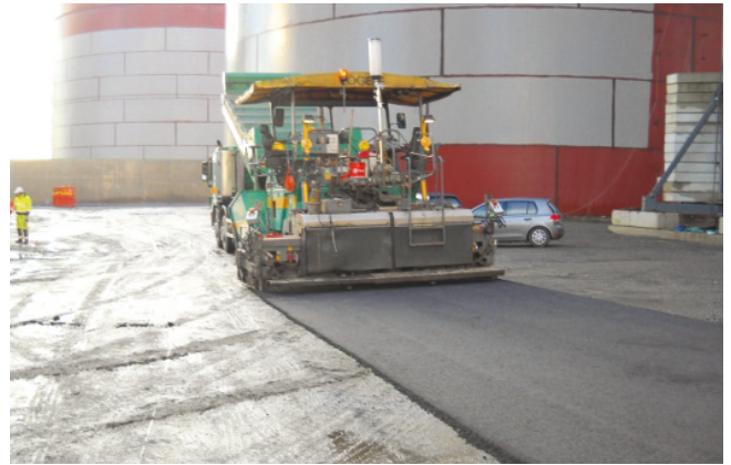
Een dunne laag asfalt wordt aangebracht op de nieuwe fundering
