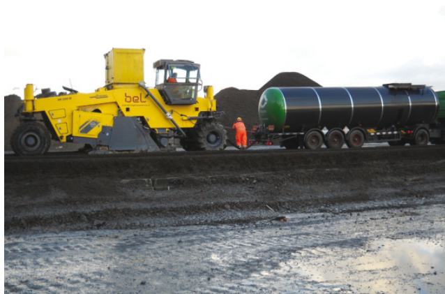
De WR 2500 freemachine wordt gekoppeld aan een bitumentruck
